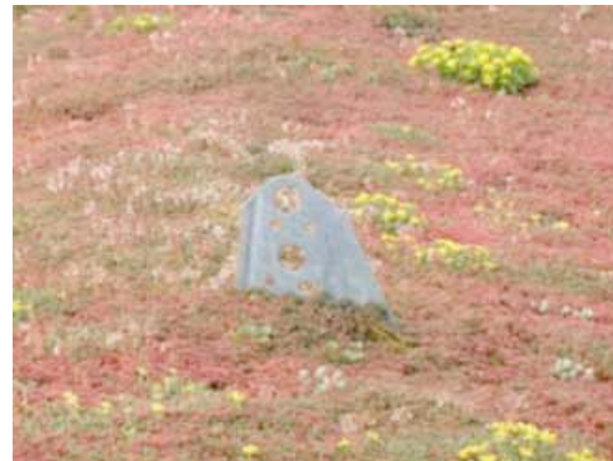
Kuva 17-13 Turvavaljaiden kiinnityspidike maksaruohokatolla. (Kuva Aino-Kaisa Nuotio)
