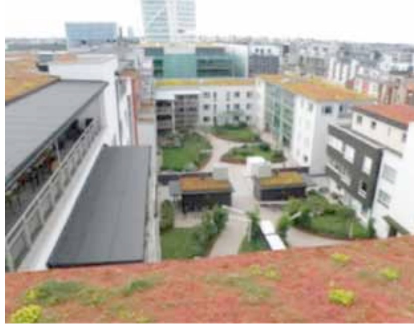
Kuva 17-11 Maksaruohokattoja (Veg Teg) Malmön Västra Hamnenin alueella. (Kuva Aino-Kaisa Nuotio)
