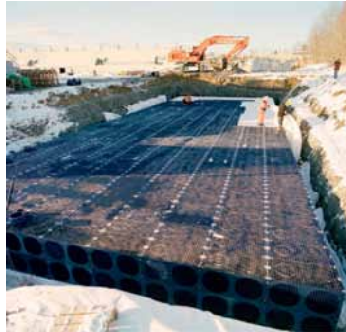
Kuva 14-5 Maanalainen muovikaseteilla täytetty imeytys/viivytyskaivanto (Wavin Labko Oy).
