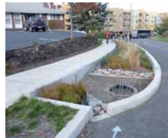
Kuva 9-5 Hulevesijärjestelmän yhteyteen tehty painanne, johon hulevesi pääsee purkautumaan ritiläkaivon kautta, Portland, Oregon, USA (Jukka Jormola)
