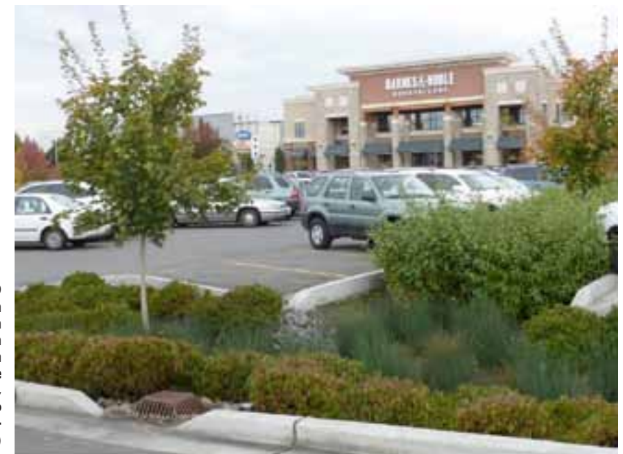
Kuva 19-9 Liikekeskuksen aiemmin yhtenäisen pysäköintialue on saneerattu johtamalla vesiä uusille biopidätysalueille, Seattle, (hulevesikaivo toimii vain ylivuotovesille). (Jukka Jormola)
