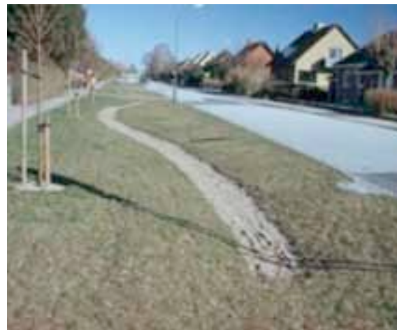
Kuva 17-7. Sorapainanne. Vesi johdetaan nurmetetun erotuskaistan sorapainanteeseen, josta se imeytyy sorapinnan kautta. Hoitotoimenpiteenä on ruohonleikkaus ja roskien poisto sorapinnalta.
