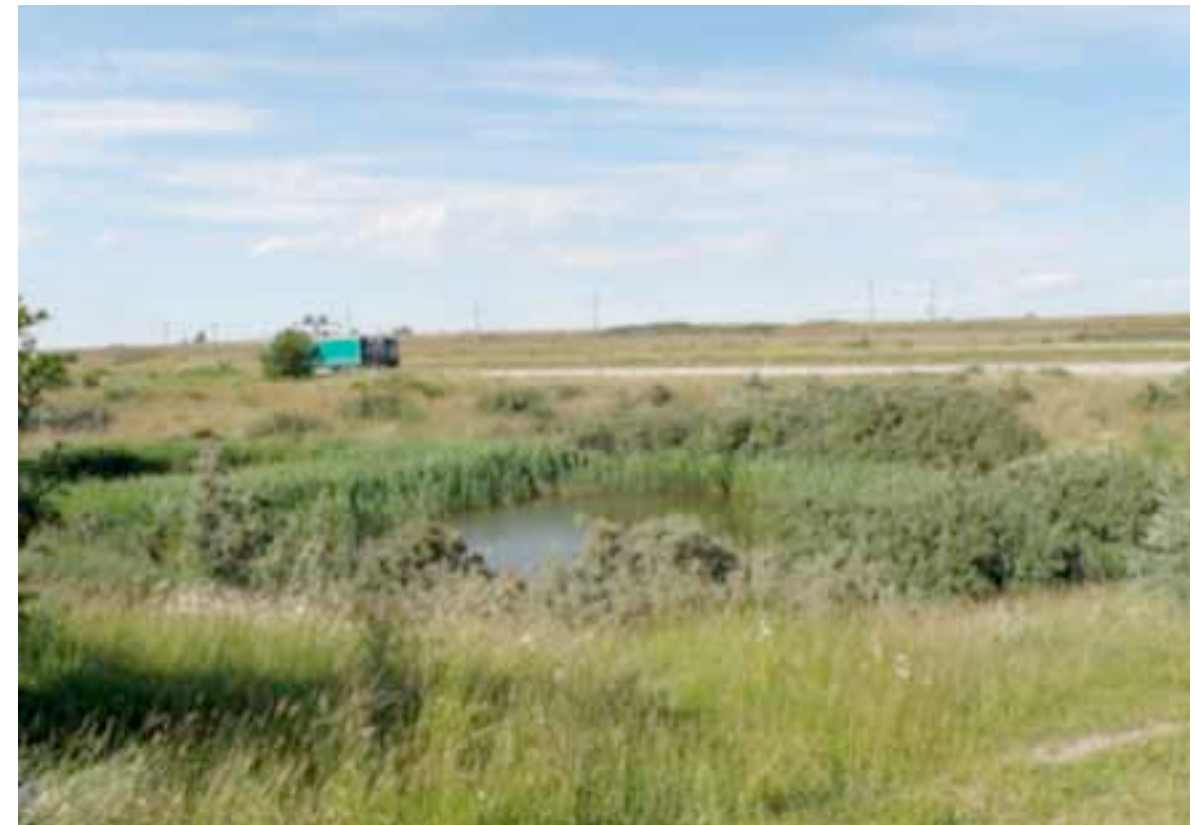
Kuva 17-22 Laskeutusallas ja kosteikko (kaksi erillistä allasta) tien kuivatusvesien puhdistami- seen ja viivyttämiseen tarkoitettua allasta Malmössä. (Kuva Aino-Kaisa Nuotio)
