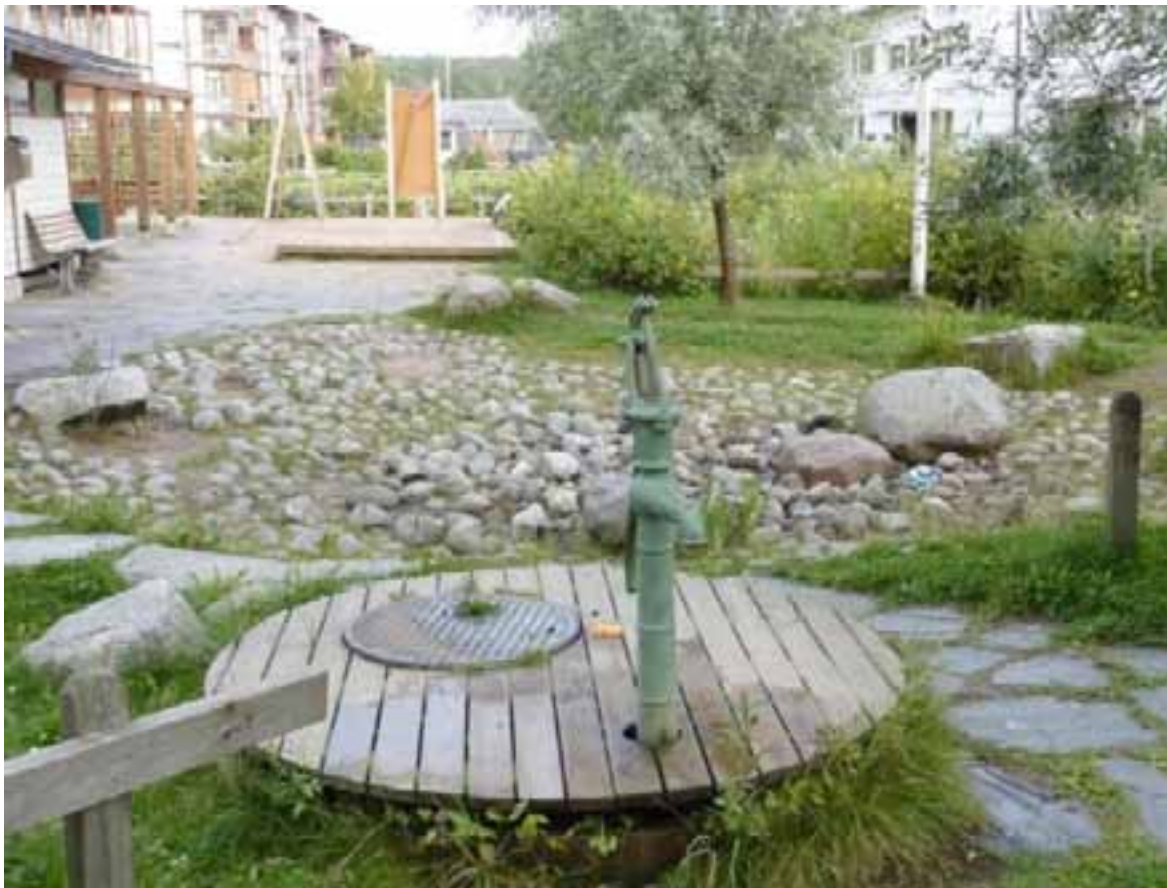
Kuva 19-5 Sadevettä kerätään katoilta pumpulla käytettävään säiliöön ja lisäksi kivipäällysteeseen imeytyspainanteeseen Viikin ekorakentamisalueella. (Jukka Jormola)
