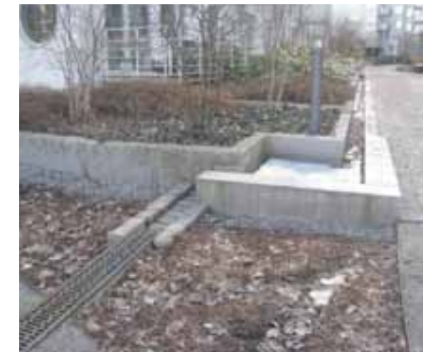
Kuva 19-12 Hulevesiä johtava kivetty kouru laatoitusalueella, Tukholma. (Jukka Jormola)
