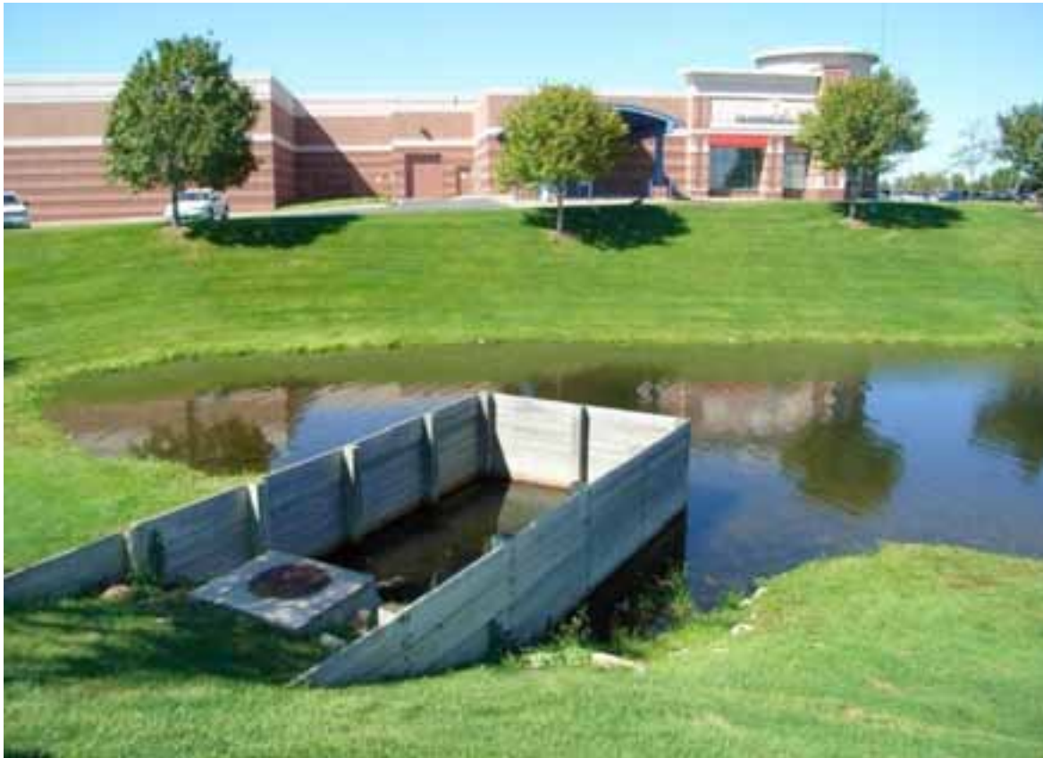
Kuva 19-14 Lammen poistoputken ympärille tehty kehikko, joka mahdollistaa tilapäisen vedenpinnan nousun talvisateilla ja sulamisaikaan, Minnesota. (Jukka Jormola)
