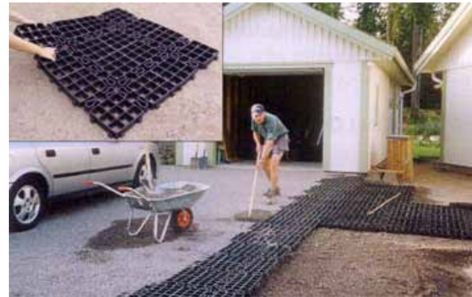
Kuva 14-2 Havainnekuva kennosoran käytöstä (Veg Tech Finland Oy).
