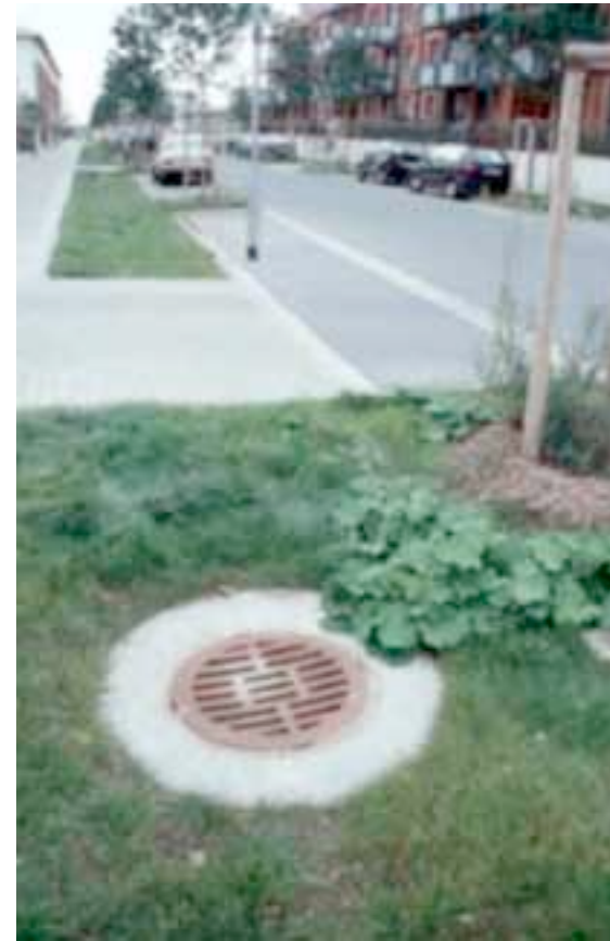
Kuva 17-9. Tulvaoja ja imeytyskaivo.
