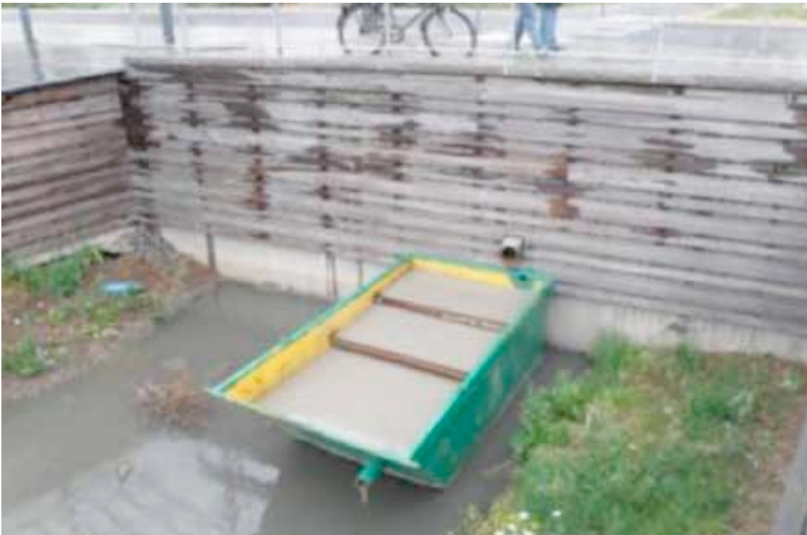
Kuva 17-23 ja kuva 17-24. Kadun kuivatusvedet ohjataan teknisesti toteutetun altaan kautta vesistöön. (Kuva Aino-Kaisa Nuotio)
