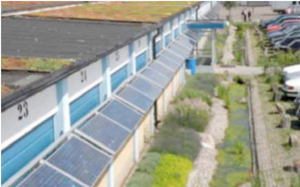
Kuva 17-27 Malmön Augustenborgin alueen viherkatto ja kosteikko. Veden pääsy rakenteisiin tulee estää. (Kuva Aino-Kaisa Nuotio)
