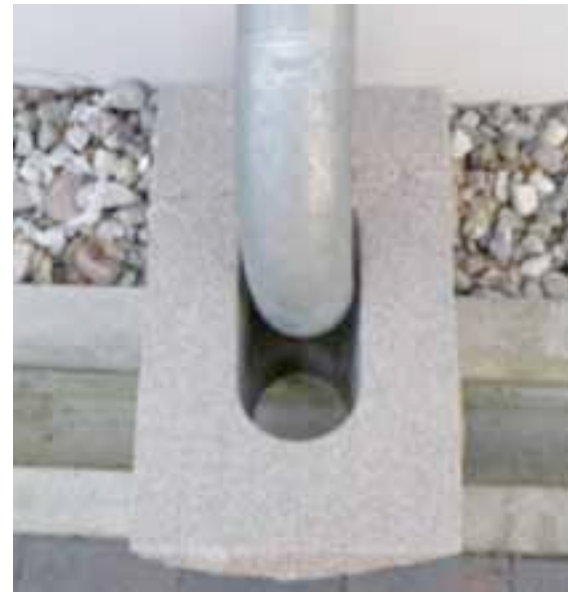
Kuva 17-15 Kattovesi ohjataan kourulla vesialtaaseen. (Kuva Aino-Kaisa Nuotio)
