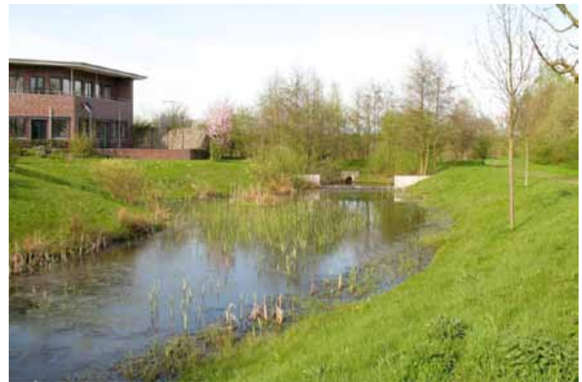
Kuva 14-45 Rakennettu kosteikko, Hampuri (FCG).
