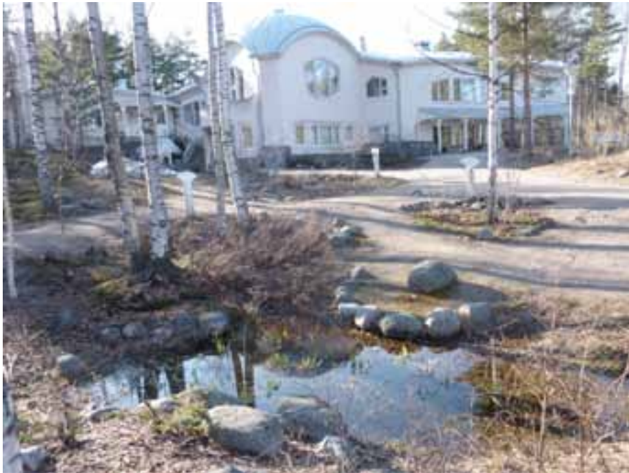
Kuva 19-10 Sadeveden viivytylammikko, jossa pohjan tiivistys mahdollistaa vesipinnan säilymisen kuivimpia aikoja lukuun ottamatta, Helsinki. (Jukka Jormola)
