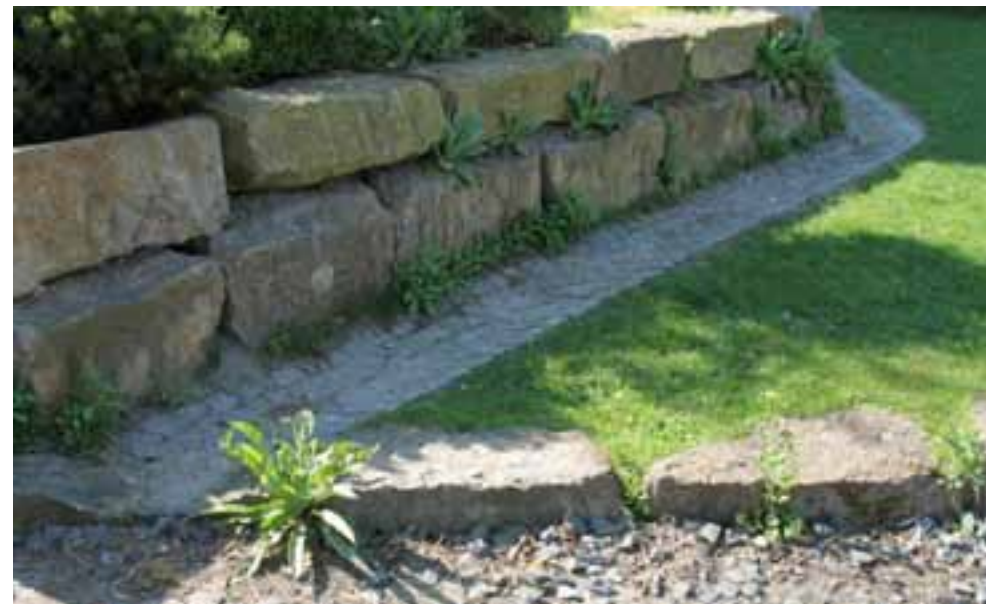
Kuva 14-37 Esimerkki kivetyn painanteen käytöstä, Hannover (FCG)
