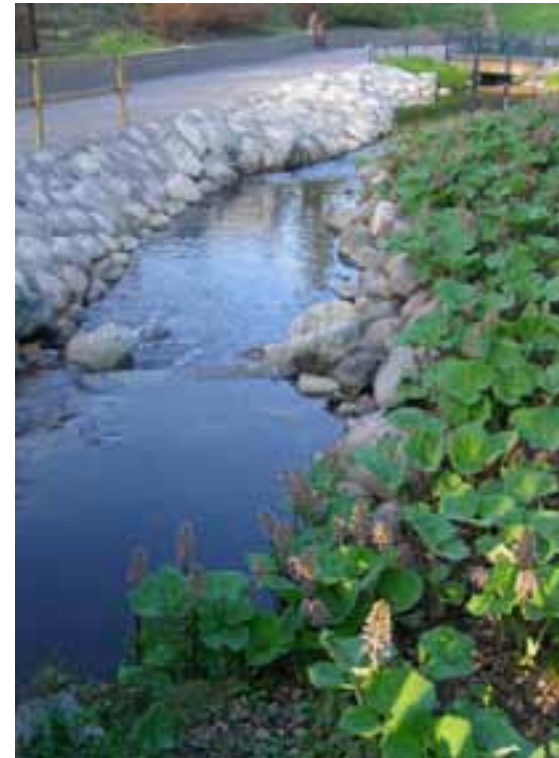
Kuva 16-3. Vas. Puron rakennettua ja istutettua rantaa Helsingin Aarrepuistossa. (Kuva Jan Tvrdy).
