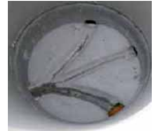
Kuva 14-60 Betonisen tarkastuskaivon pohjan muotoilu (Pekka Laakkonen).
