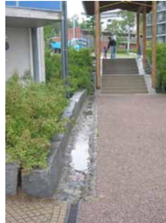
Kuva 19-11 Hulevesien johtamiseen voidaan käyttää luonnonkivistä tehtyjä kouruja, Viikki. (Jukka Jormola)
