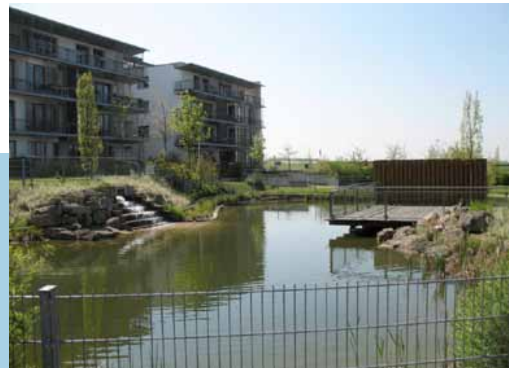
Kuva 14-52 Rakennettu allas, Hannover (FCG).
