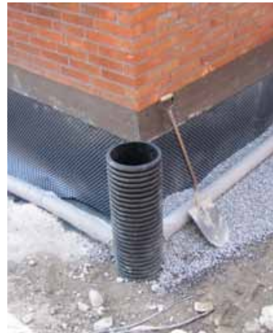
Kuva 18-3 Kuitukankaalla suojattu salaojat ja salaojakaivo. (Tapio Helenius)
