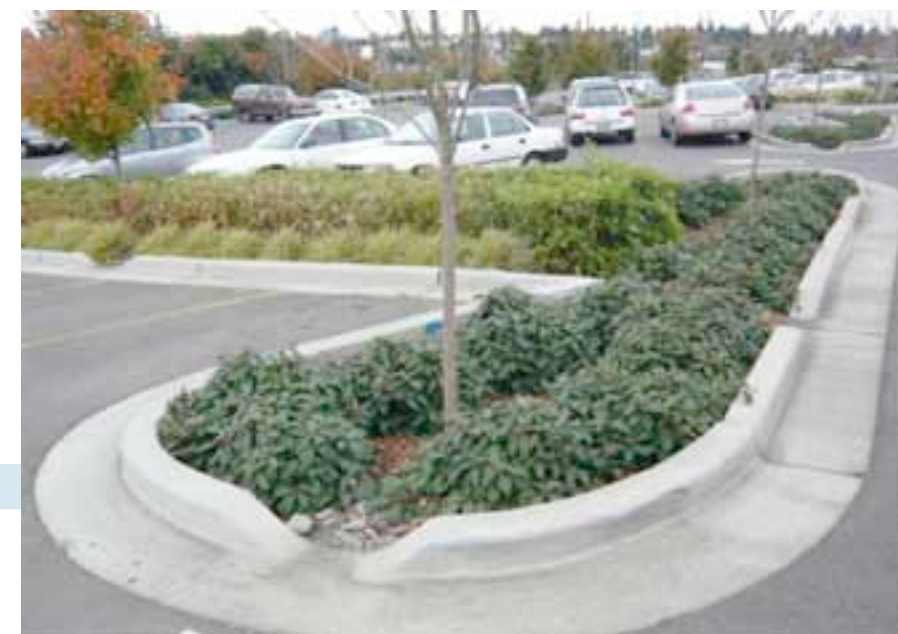
Kuva 14-13 Esimerkki imeytyspainanteesta pysäköintipaikan vieressä, Seattle (FCG).
