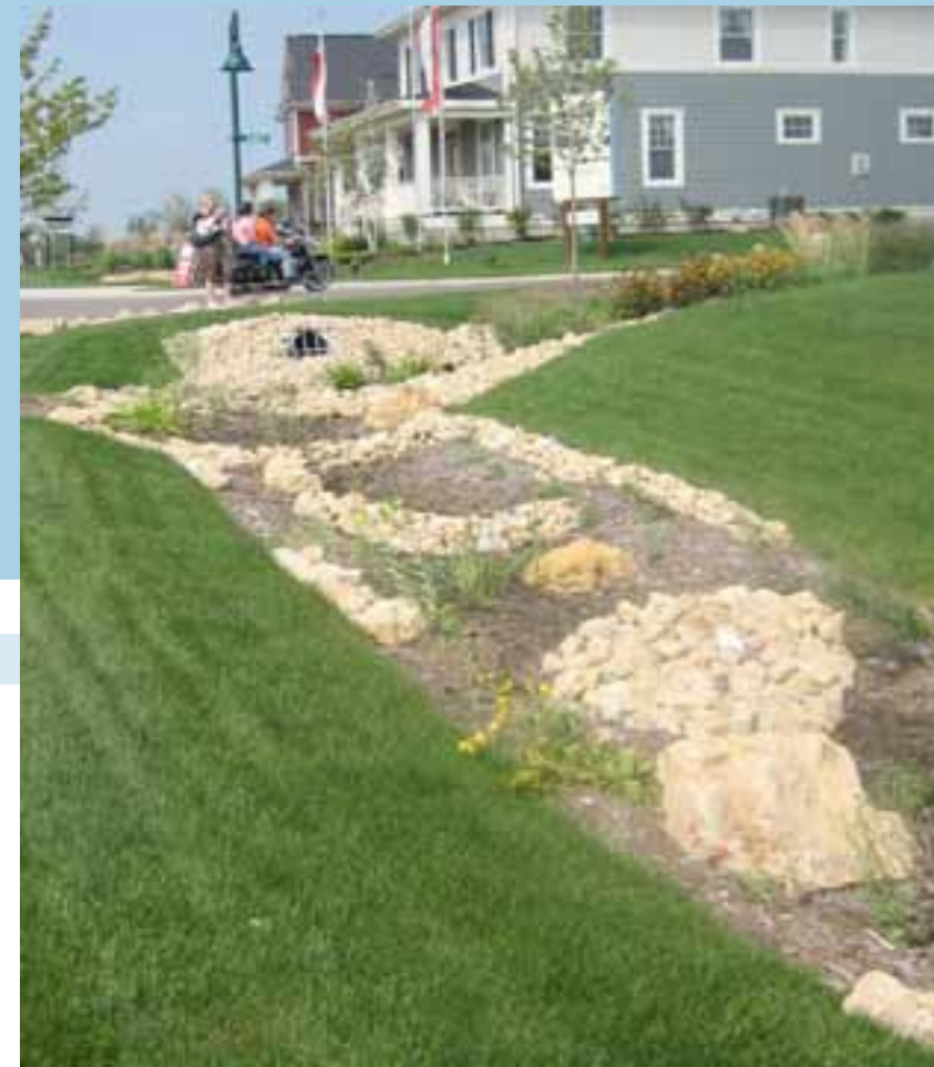
Kuva 14-25 Kaltevissa painanteissa virtausta voidaan hidastaa patoamalla, Minnesota (FCG).
