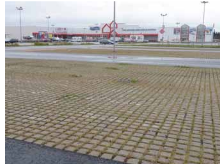
Kuva 19-6 Laatoitukset toimivat läpäisevänä päällysteenä pysäköintialueen vähemmän käytetyllä osalla, Oulu. (Jukka Jormola)
