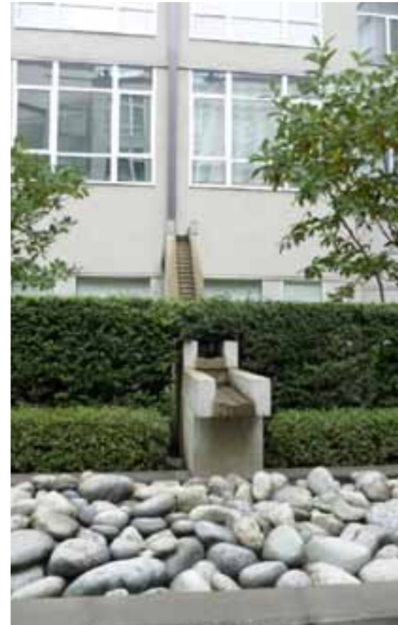
Kuva 19-3 Kattovesiä johdetaan kourulla imeytysaltaaseen etäällä rakennuksesta, Portland – Suomen olosuhteissa tulee ottaa huomioon jäätyminen. (Jukka Jormola)
