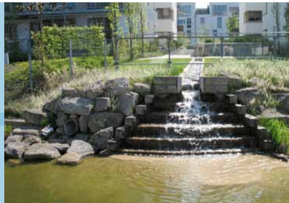
Kuva 14-49 Yksityiskohta lammikosta, tulovirtaaman hajottaja.
