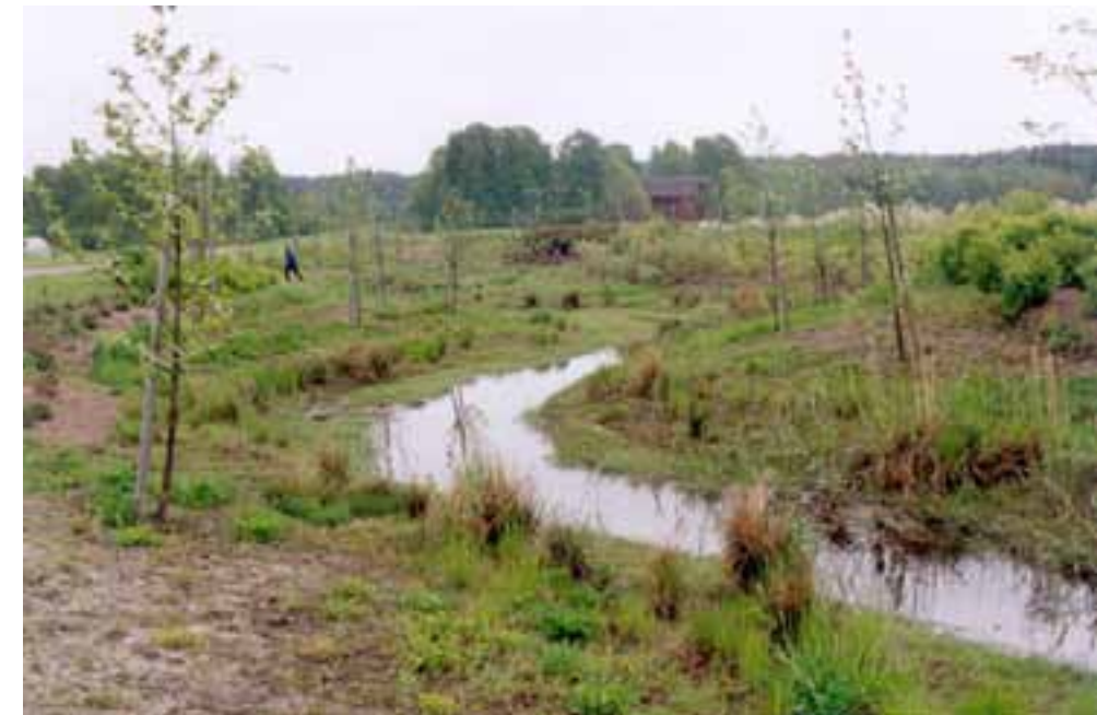
Kuva 16-10 Helsingin Viikinoja mutkittelee peltomaisemassa. Muotoiltu purouma siirrettiin nykyiselle paikalleen Viikin alueen rakentamisen myötä. Tulva-aikaan vesi voi nousta loiville tulvaniityille. (Kuva Eeva Eitsi)
