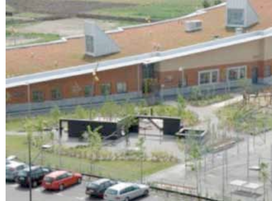
Kuva 17-12 Vasta rakennettu koulurakennuksen maksaruohokatto (Veg Teg) Malmön Västra Hamnenin alueella. (Kuva Aino-Kaisa Nuotio)
