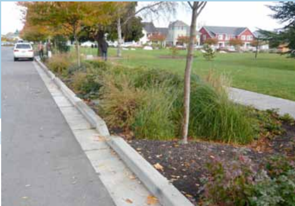
Kuva 14-23 Katuvesiä johtava ja imeyttävä painanne (FCG).
