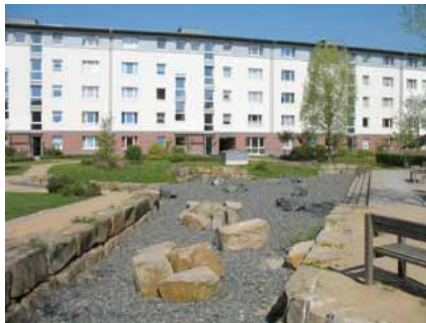
Kuva 14-7 Avoimen imeytyskaivanto kerrostalon piha-alueella, Hannover (FCG)
