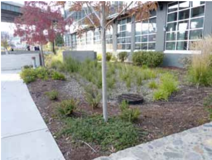
Kuva 19-7 Sadevesien imeytyspainanne, jossa hulevesikaivo toimii ylivuotona. Vettä esiintyy painanteessa vain sateella, Portland. (Jukka Jormola)
