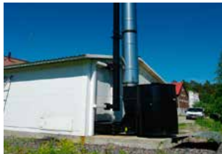
Tutkintakohde oikealta takakulmasta
