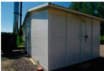
Tutkintakohde vasemmalta takakulmasta
