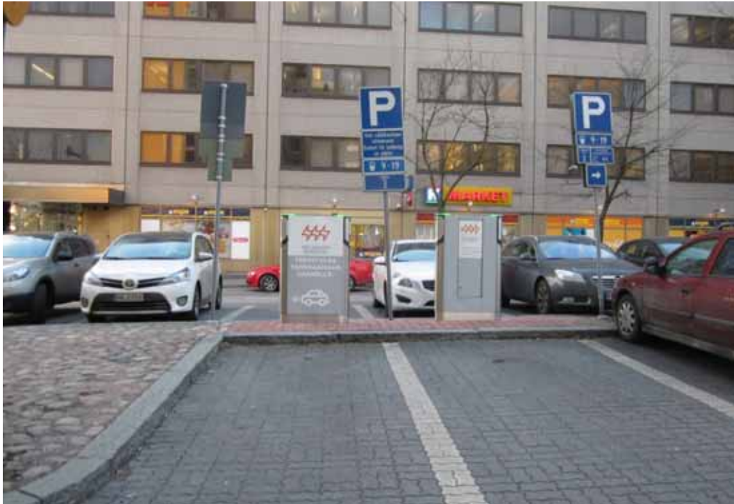
Kuva 22. Helsingissä Esterinportin sähköauton latauspisteet neljälle ajoneuvolle sijoitettuna korotetulle välialueelle (Sito 2015)
