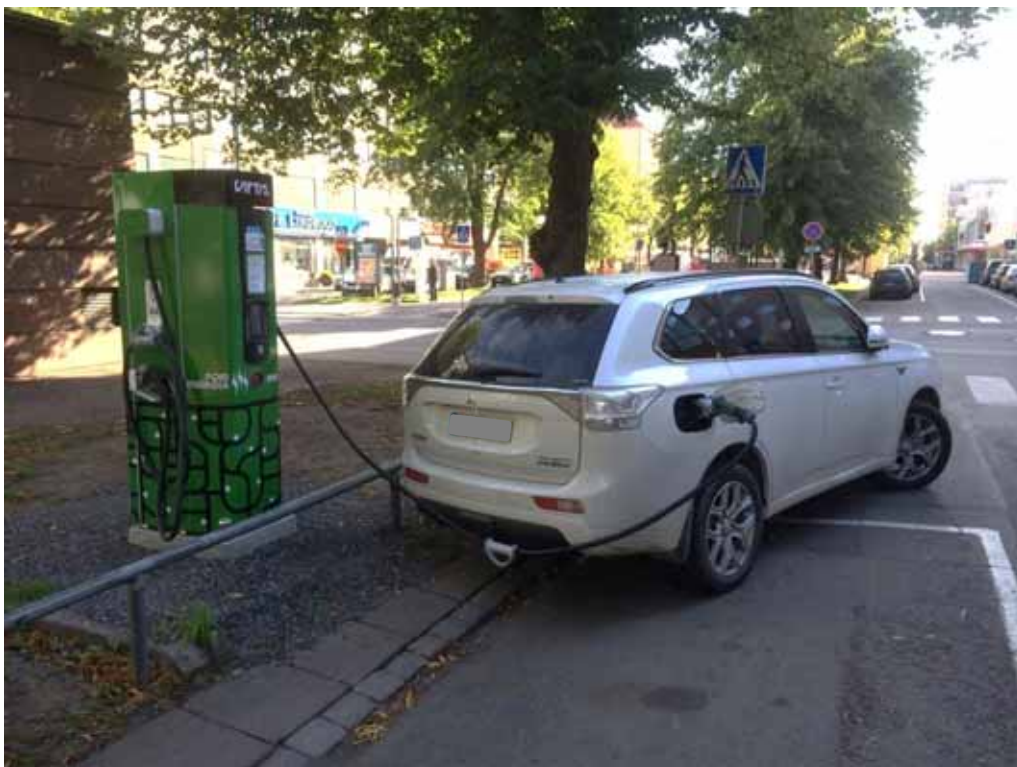
Kuva 21. Porin keskustassa kadunvarsipaikoituksessa sijaitseva pikalatauspiste (Lumioksa 2015).
