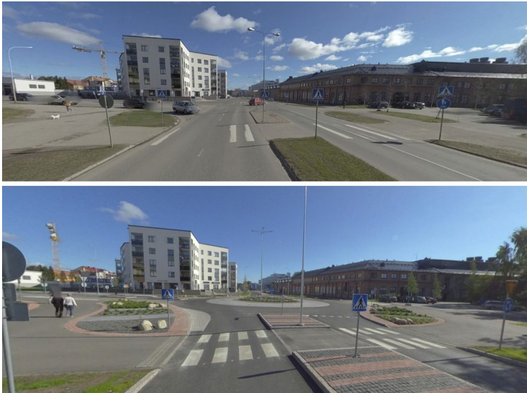
Kuva 7. Rovaniemellä kanavoitu liittymä on muutettu kiertoliittymäksi ydinkeskustaa kiertävällä kehällä (kuvat: Rovaniemi, linkki Mapillary-kuvaan , HTJoy, lisensoitu CC-by SA:lla ).
