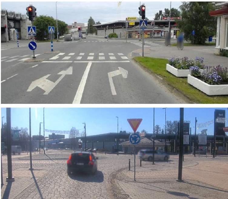
Kuva 8. Kuusamon keskustassa liikennevalo-ohjattu ja kanavoitu liittymä muutettiin kiertoliittymäksi ja samalla väylä muutettiin pihakaduksi. Taustalla tori. (Tiekuva, Väylävirasto)
